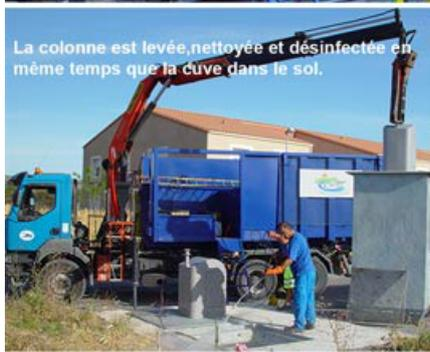
La colonne est levée, nettoyée et désinfectée en même temps que la cuve dans le sol.
